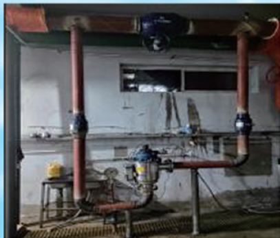
现场安装照片
