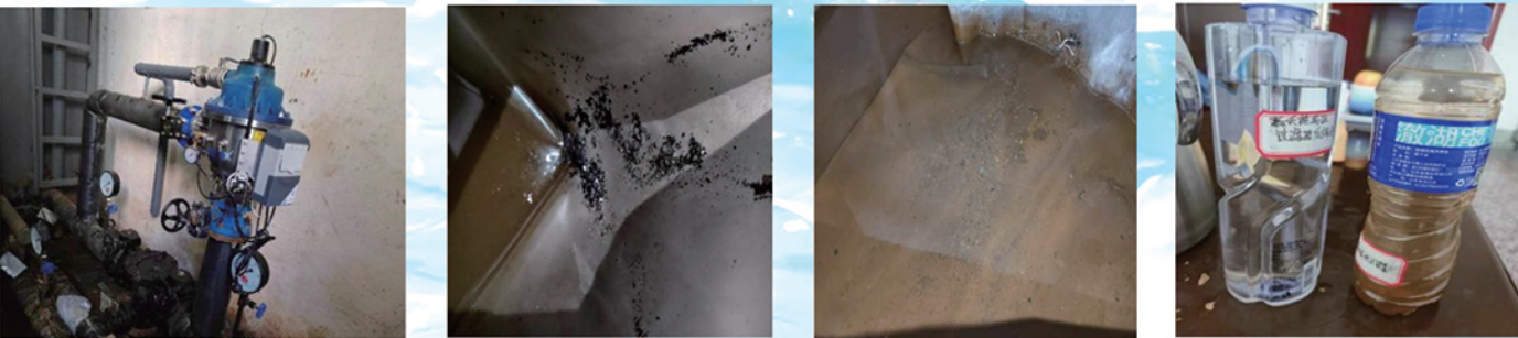
现场安装照片
