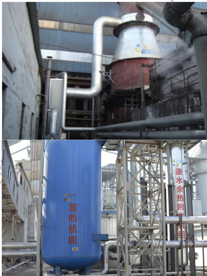
图 5-46：项目蒸汽负压余热回收装置和蓄热机组实景图
