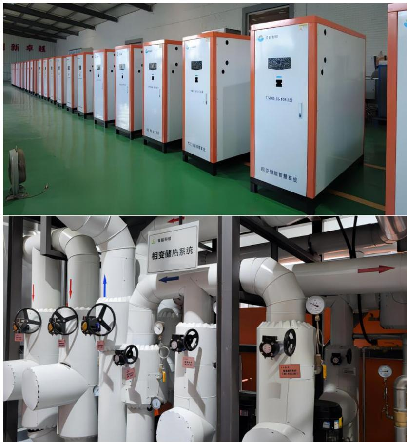
图 5-21：辽宁邮电智慧相变蓄热储能系统实景图
