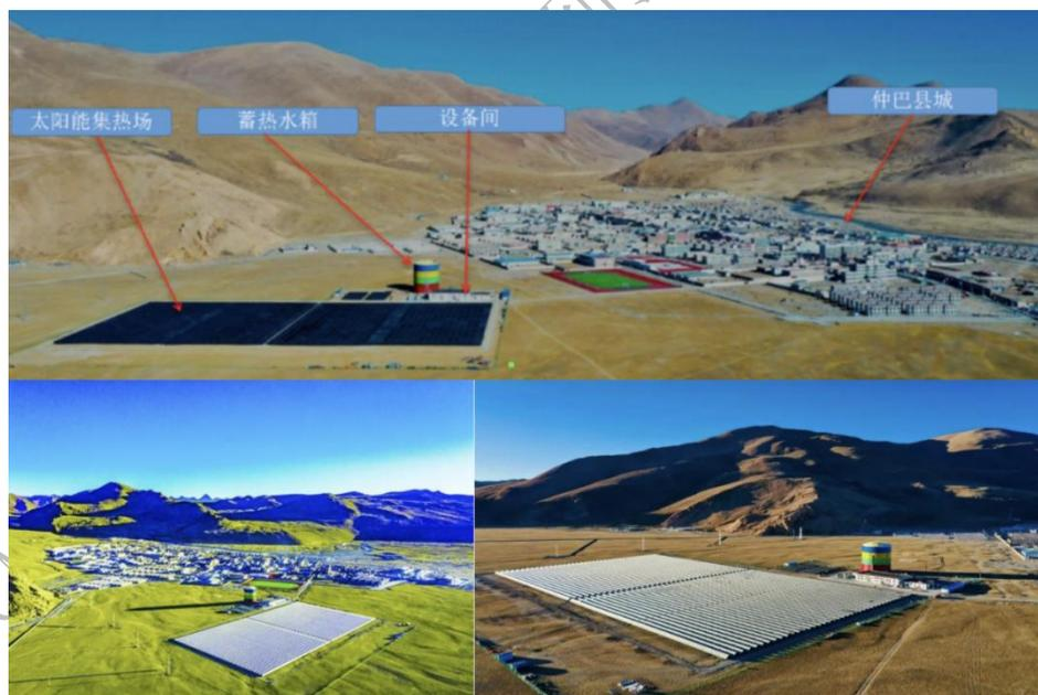
图 5-15: 西藏仲巴县大型太阳能集中供热项目实景图
