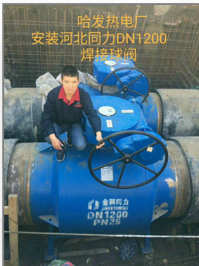
哈尔滨发电热电厂安装现场
