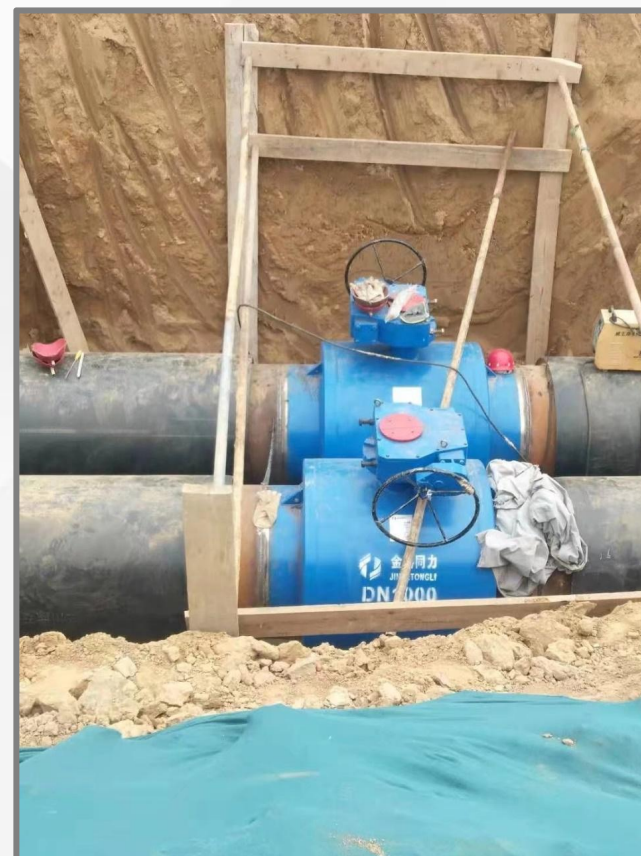
烟台500供热有限公司安装现场
