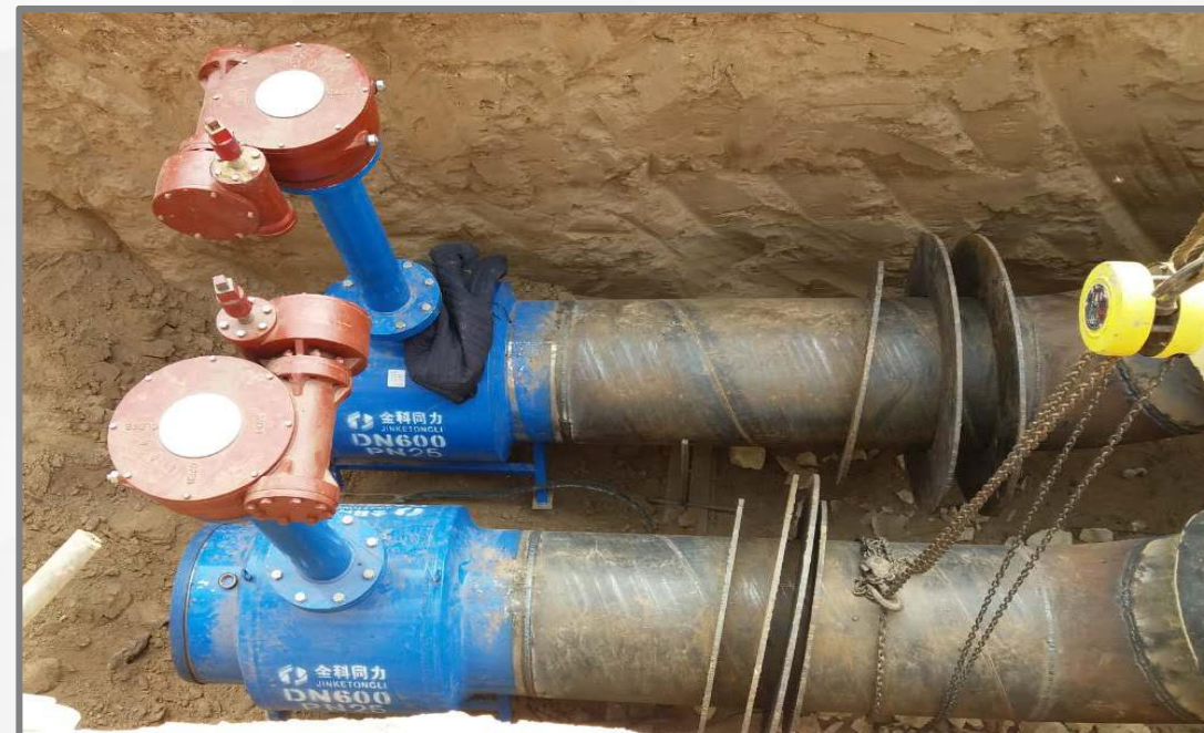
鄂尔多斯市大兴热电有限责任公司安装现场
