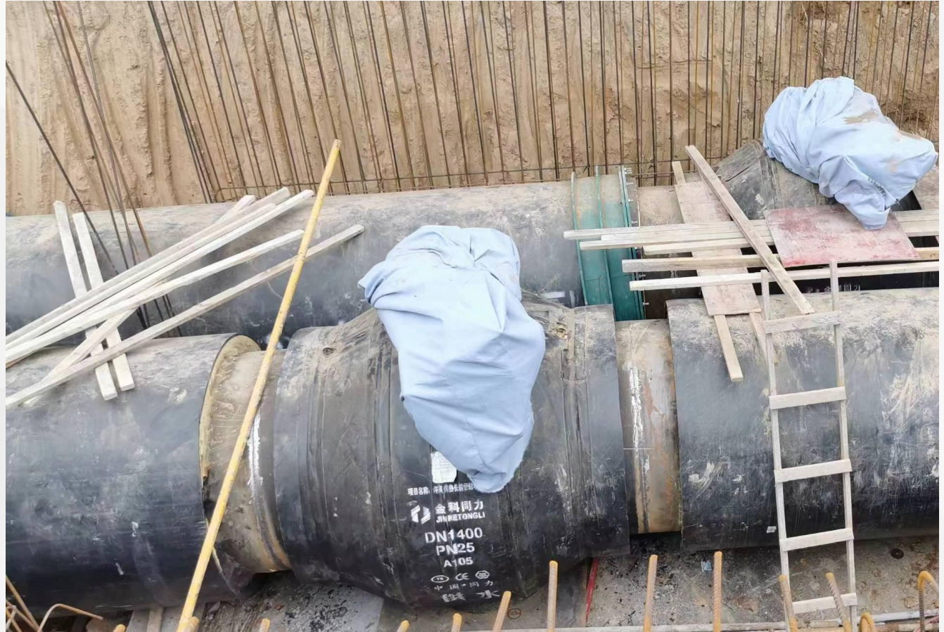
施工现场图片
