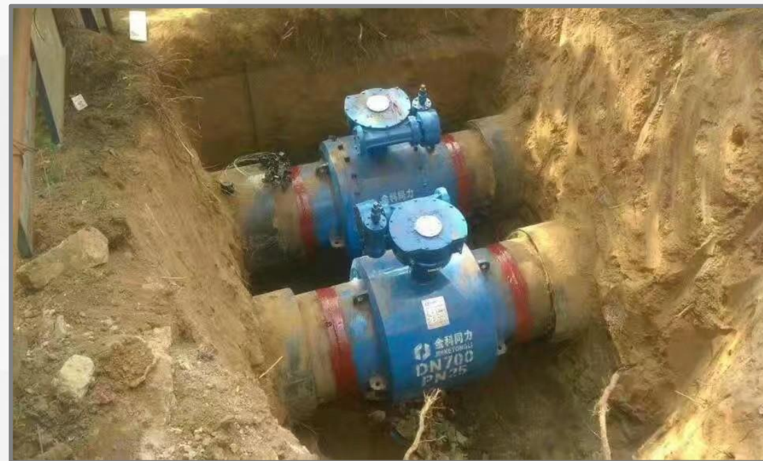
张家口市市政公用热力有限责任公司安装现场
