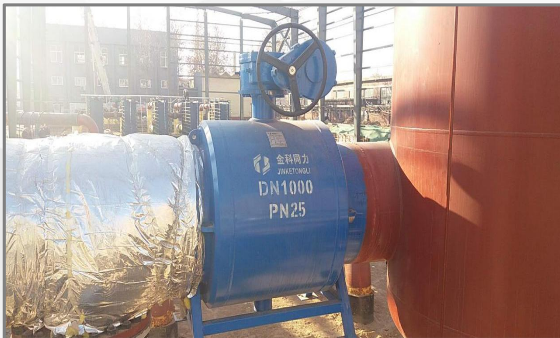
石家庄西岭供热有限公司安装现场
