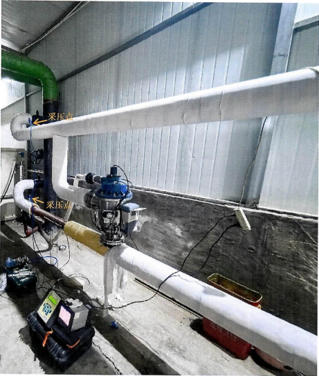
图 4 采压点选在除污器前后连接管路处
