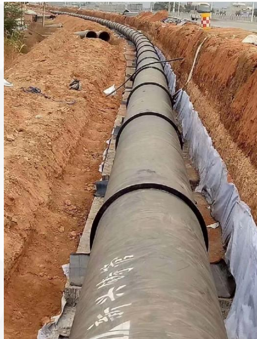
球管利用接口偏转曲线安装
