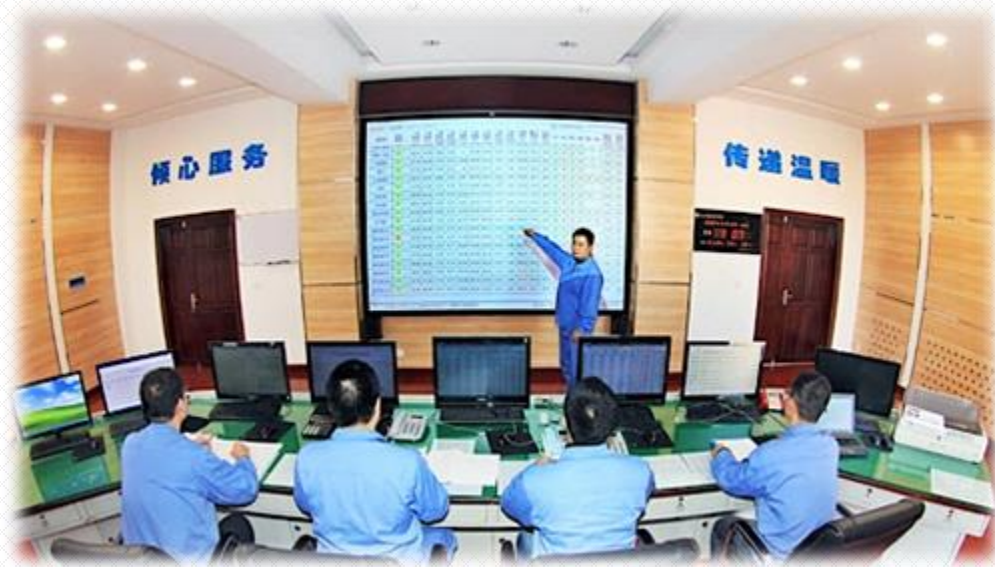
智能监控平台中控室
