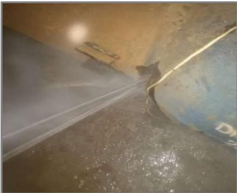
DN1000椭圆形结构焊接球阀撕裂现场
