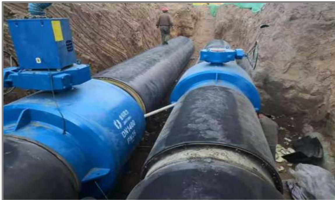
石家庄环网供热有限责任公司于2020年10月21日至2021年6月21日，对石家庄热电厂和古城路供热输配线进行连接，管沟总长约5.8公里，管径DN1400。共采用同力大口径DN1400全焊接球阀7台，管线路由：从古城东路南经翟营大街到石德铁路北路、沿石德铁路北路向西过华清街穿越石德铁路至石热东厂区，投入运行后，各项技术指标均能满足需方要求。
