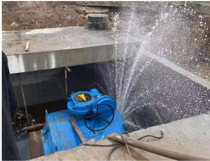
DN1400钢板制作焊接球阀撕裂现场
